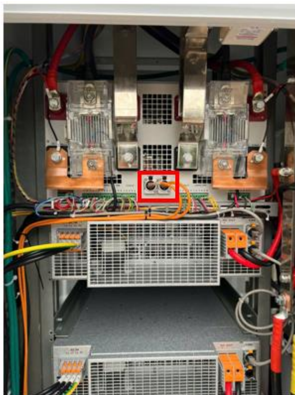
Hình 24: Hình ảnh đấu nối thực tế dây mạng vị trí khối điều khiển
