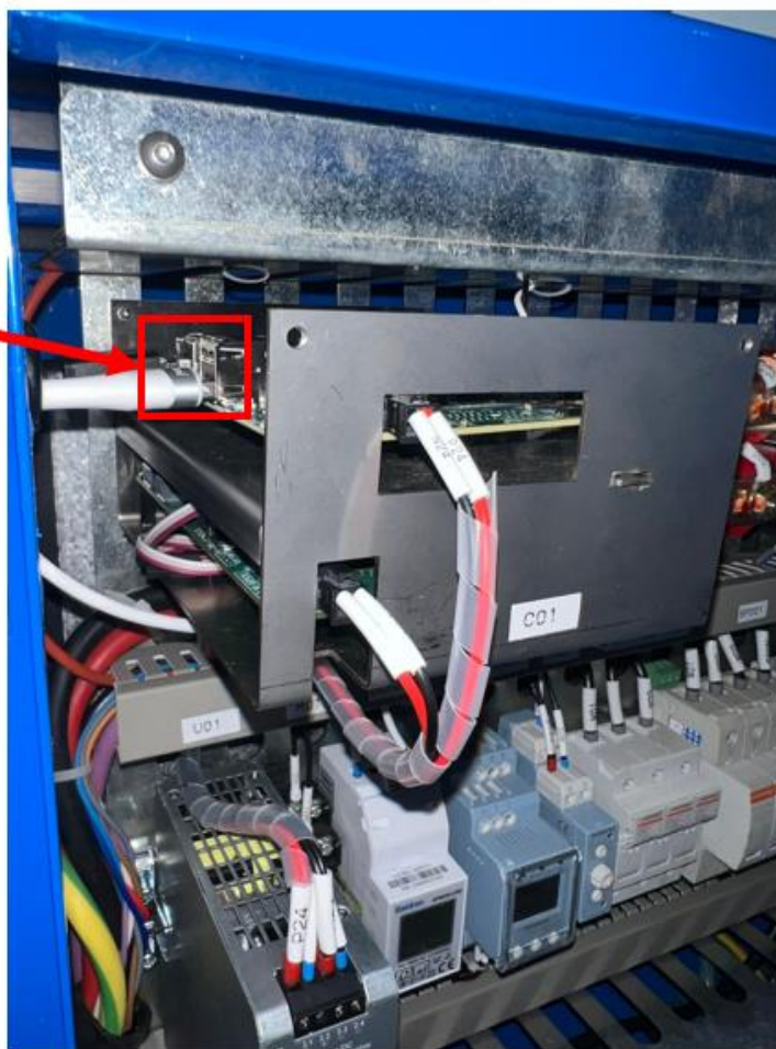
Hình 15: Vị trí đấu nối dây mạng trong trụ
